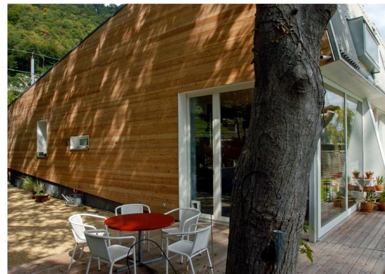
Der Wohnbereich des bestehenden Winkelbaus wurde vorsichtig rückgebaut und die kleinteiligen Zellen des verbleibenden Riegels freigelegt. Über die neue, geklärte Situation wurde eine grosszügige, mit Welleternit gedeckte Holzhalle errichtet. Es entstand ein Haus, in sich so komplex und gleichzeitig aber so einfach - als würde mit dem Massstab gespielt.
