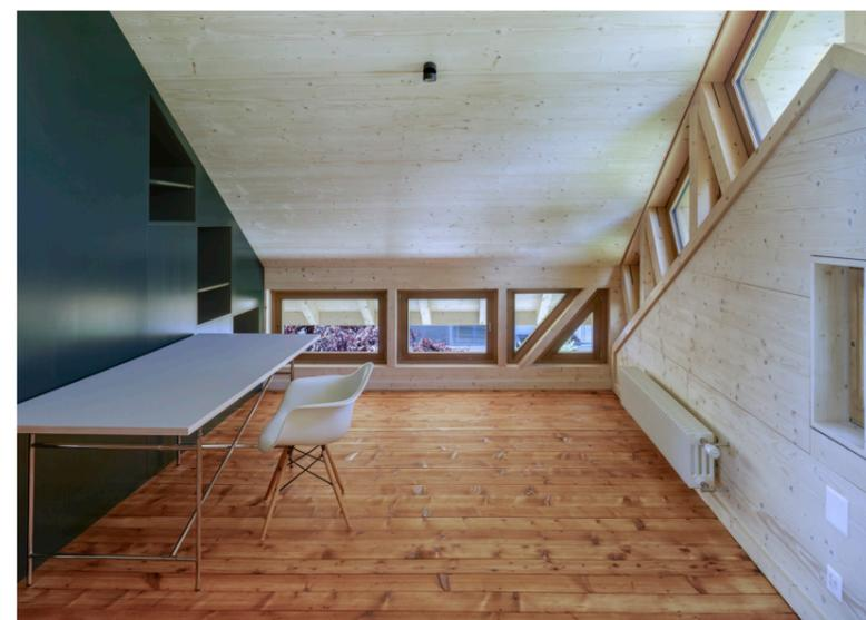
Zusammenarbeit mit dem Holzbauingenieur gelöst werden konnten. Durch die Verwendung eines Fachwerks an den Giebelseiten konnten sogar die kleinen Fenster, die ehemals für die Belichtung und Belüftung des Estrichs gedacht waren, als Relikte an den Bestand erhalten werden.
