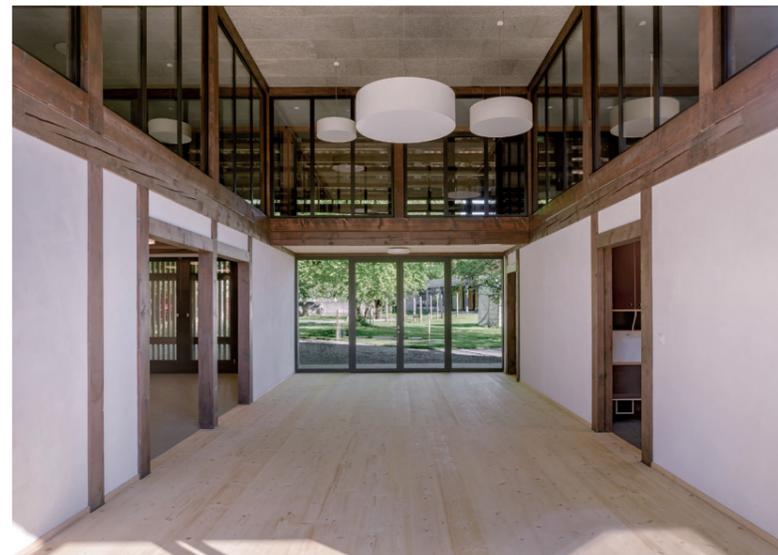
Der Baukörper mischt sich aus Massiv- und Ständerbau und ist durch ein geknicktes, abgewalmtes Satteldach gedeckt. Die Innenkonstruktion besteht grösstenteils aus einer Freibundkonstruktion aus den 70er Jahren.
