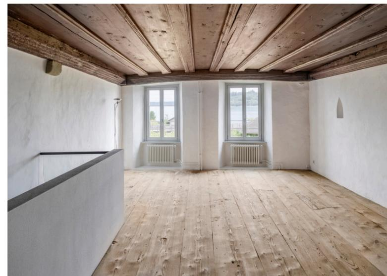
Da die bestehende Bausubstanz sorgfältig rückgebaut wurde, konnten die darunterliegenden, hochwertigen Oberflächen unverletzt zum Vorschein gebracht werden. Diese zu erhalten und restaurieren war Kern der Sanierung und ist durchaus gelungen. Heute kommt einem ein Gang durch das Gebäude wie eine Reise durch die Baugeschichte vor.
