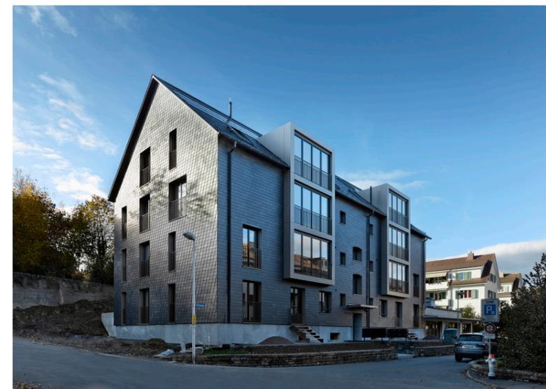
Das Mehrfamilienhaus wurde mit Decke über Untergeschoss neu in konventioneller Bauweise aufgebaut. Die Fassade und das Dach wurden mit Naturschiefer verkleidet. Die Nähe zum Hang auf der Westseite wurde mit den Loggias aufgewertet. Wir generierten Aussenräume ohne die darunterliegenden Wohnungen mit Schatten zu benachteiligen.
