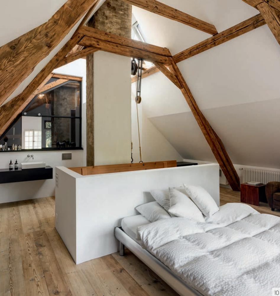
10 Der Dachraum wurde bis unter den First geöffnet, Dachschrägen wurden nutzbar gemacht und der Kamin frei gestellt. Rechts dahinter in der «Tennbox» liegt das Ankleidezimmer.
